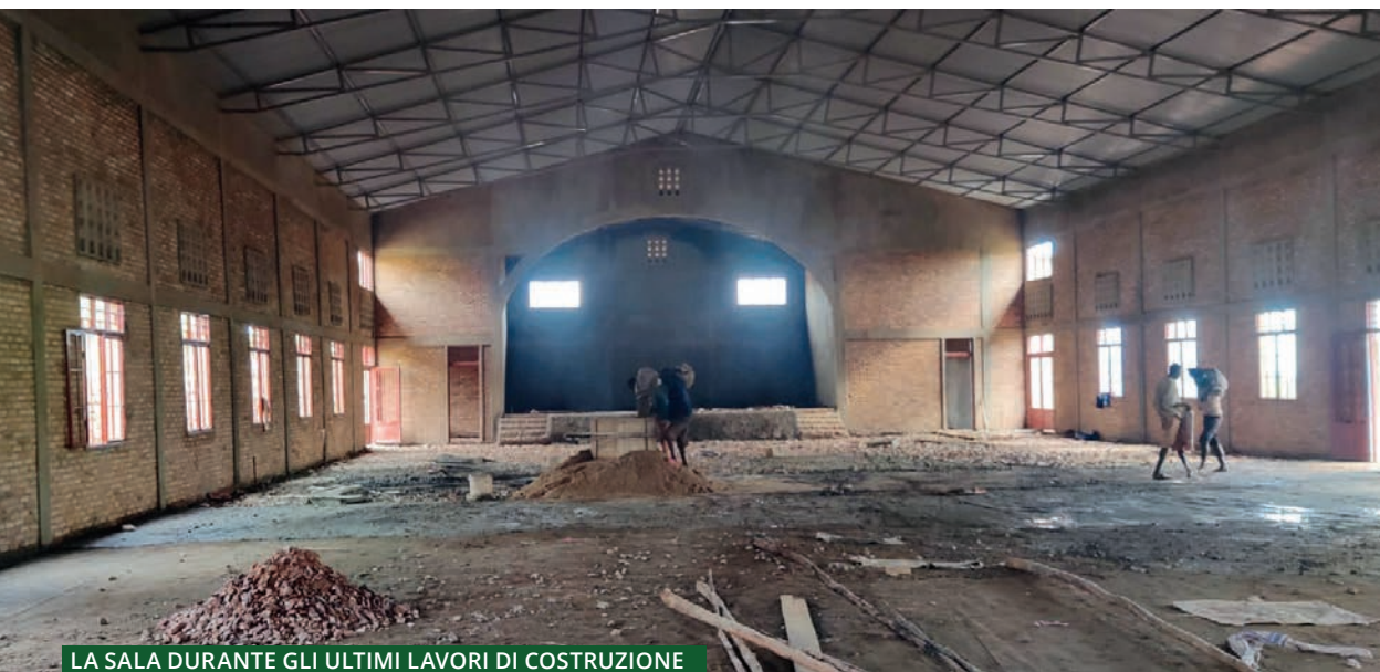
LA SALA DURANTE GLI ULTIMI LAVORI DI COSTRUZIONE
